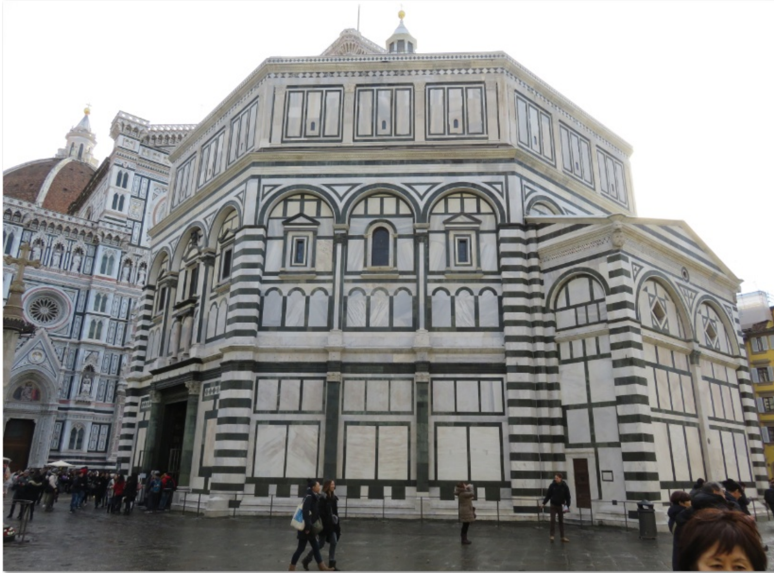
北西側から見たところ
