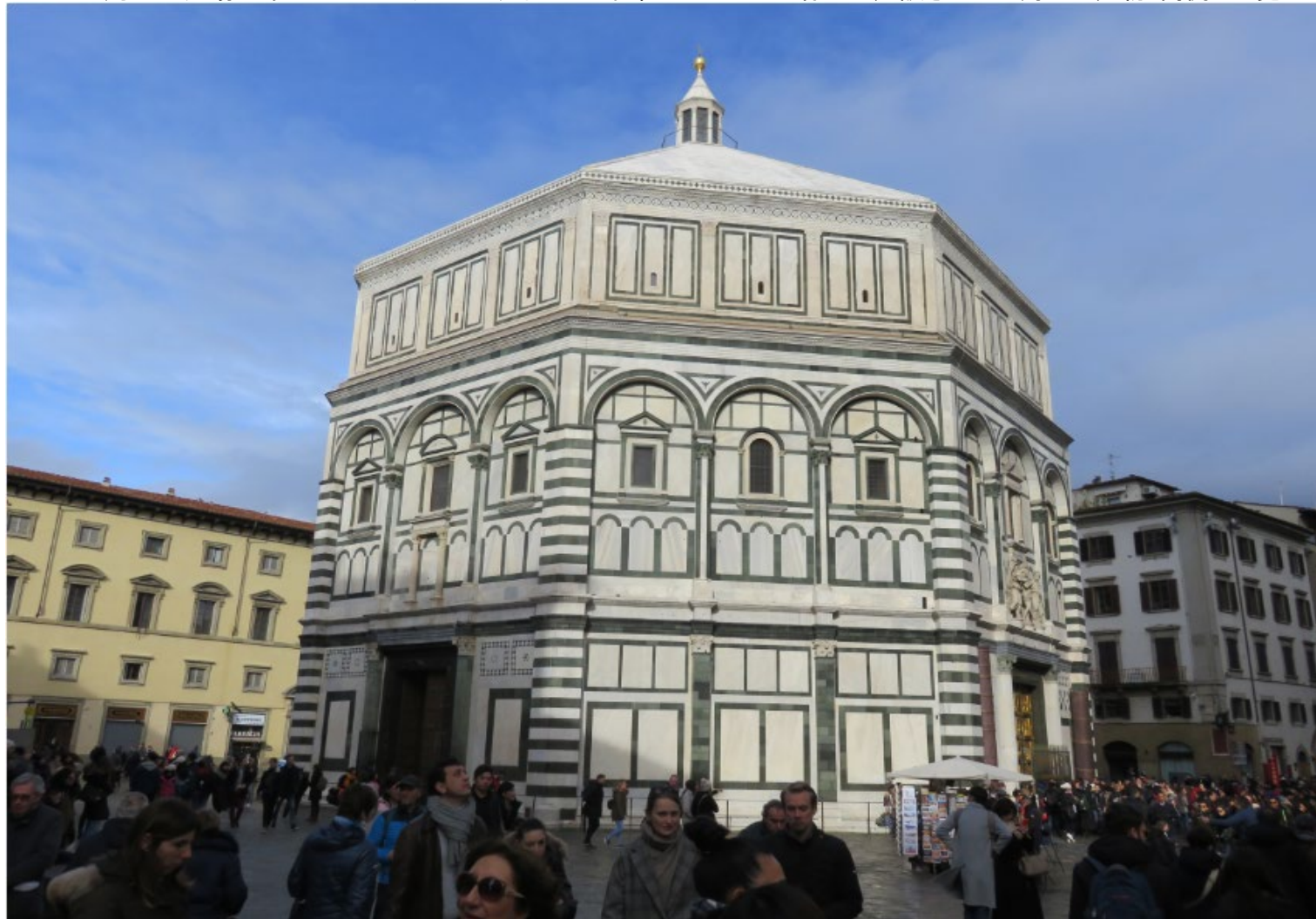
これはドゥオーモ広場にあるサン・ジョヴァンニ洗礼堂/11世紀にビザンチン様式で建設された八角形の建物/南側から見たところ
