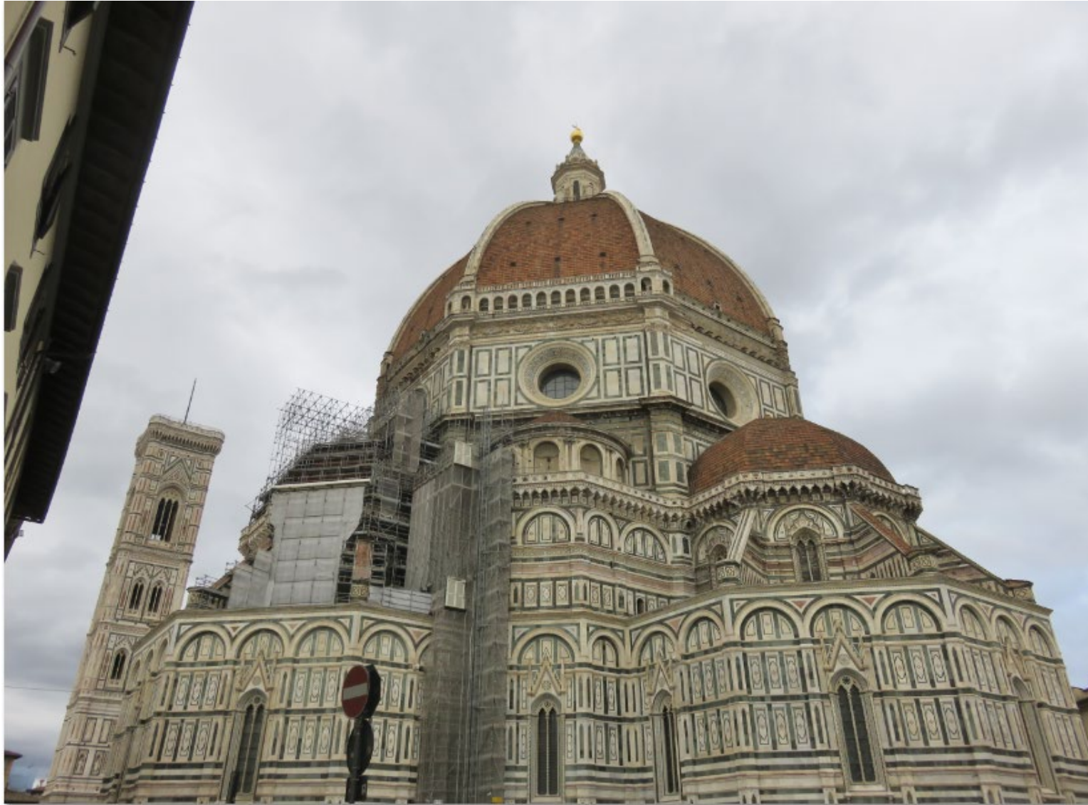
上部のクーポラ(大天蓋)を見上げたところ/クーポラはブルネレスキ設計の初期ルネッサンス様式
