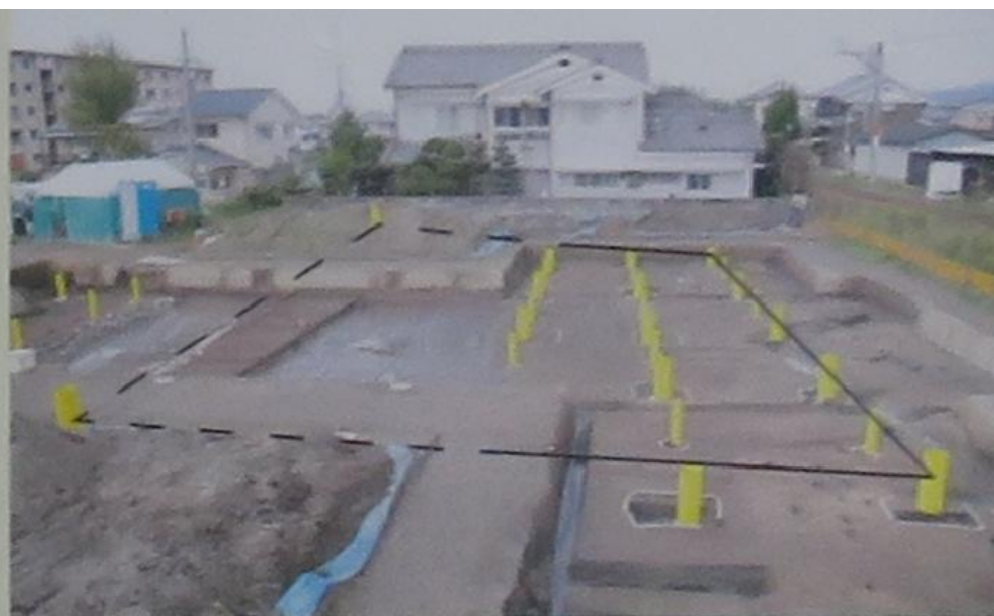
建物D(南から)
