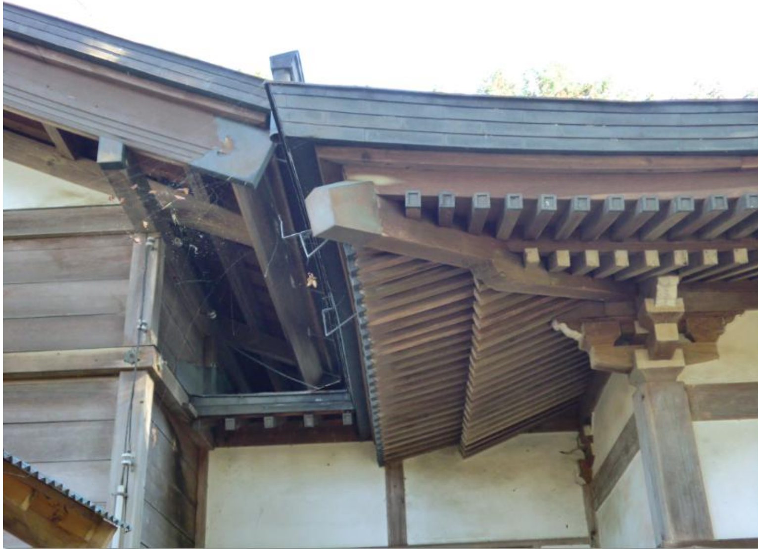
屋根取り合い部
